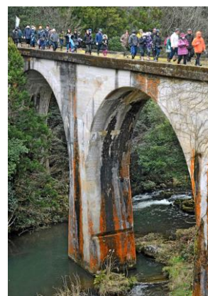
広浜鉄道遺構のアーチ橋
