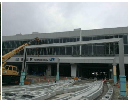
富山駅は新しい線路が引かれる工事の真っ最中だった
