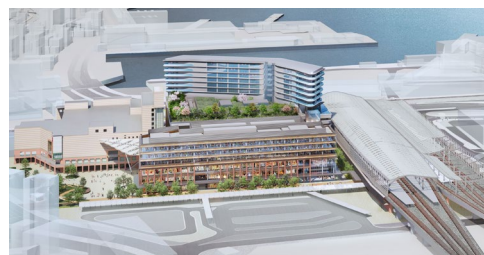
JR九州が整備する商業施設やホテルを備えた新たな長崎駅ビルのイメージ。左は既存の駅ビル、右は新駅舎（JR九州提供）
