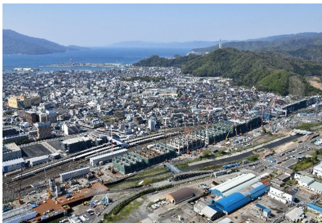
北陸新幹線の2023年春開業に向け工事が進む敦賀駅＝2020年4月25日、本社へりから撮影
