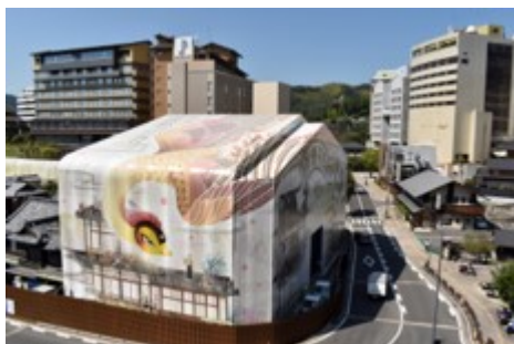
道後温泉本館の保存修理工事で、素屋根に描かれた「火の鳥」
