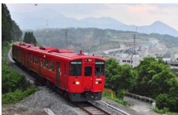
約4年4カ月ぶりにJR豊肥線が全線再開し、復旧区間を走る上りの一番列車。右奥は工事中の新阿蘇大橋 ＝8月8日午前5時50分ごろ、南阿蘇村立野
